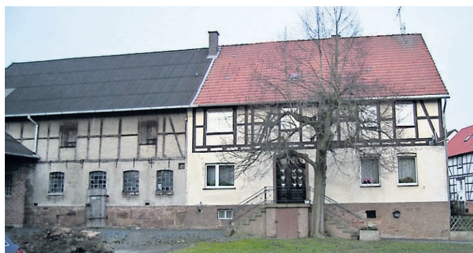
Wohnhaus und Wirtschaftsgebäude vor der Fassaden- und Dachsanierung.
