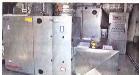
Moderne Ausstattung: Die gesamte Gebäudetechnik wurde auf den neuesten Stand gebracht. (Foto: Hennig)
